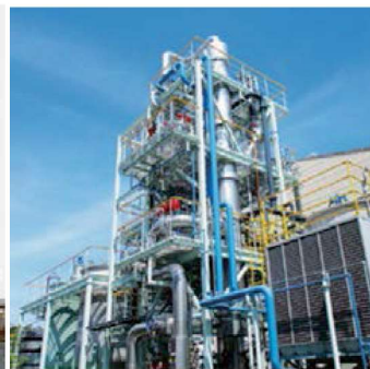
排水中のアンモニア低減を目的とした アンモニアストリッピング設備 （石原産業株式会社）
