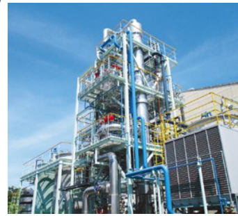
排水中のアンモニア低減を目的としたアンモニアストリッピング設備（石原産業株式会社）
