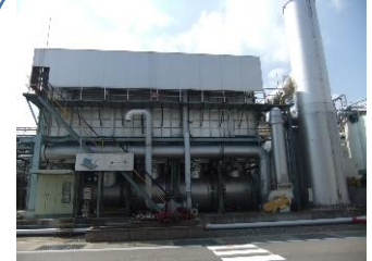
蓄熱燃焼式排ガス処理施設 （RTO）（JSR株式会社）
