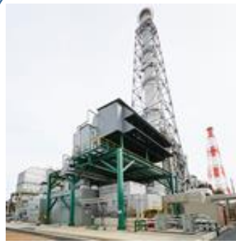
CO 2 排出を削減している ガスタービン（東ソー株式会社）
